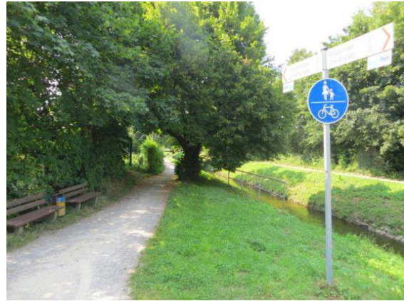
Abbildung 62: Selbstständiger gemeinsamer Geh- und Radweg entlang des Rotbachs mit erhöhtem Konfliktpotenzial zwischen Radfahrern und Fußgängern aufgrund geringer Breiten
