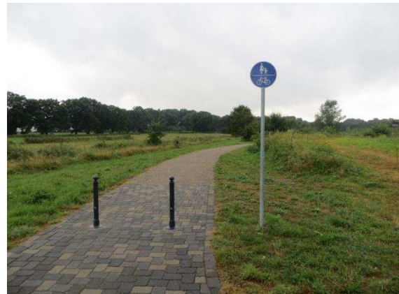
Abbildung 81: Poller mit zu geringem Abstand und ohne reflektierende Elemente an der Hühnerheide
