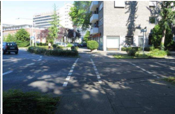
Abbildung 89: 5-armiger Kreisverkehr mit 4 unterschiedlichen Führungsformen des Radverkehrs an der Kreuzstraße/ Konrad-Adenauer-Straße
