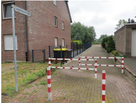
Abbildung 78: Umlaufsperrung und Poller an der Lingelmannstraße – wenig Fahrkomfort, z.T. auch Verkehrsgefahr
