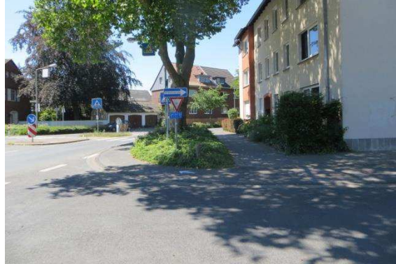
Abbildung 88: nicht eindeutige Führung des Radverkehrs aus der Einbahnstraße an der Feldstraße/ Bismarckstraße; gesprühte Pfeile weisen auf die Nutzung des Zebrastreifens hin; beobachtet wurde hingegen unterschiedliches Verhalten von Radfahrern
