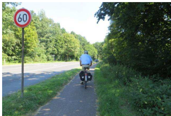
Abbildung 56: Schmalere, gemeinsamer Geh- und Radweg an der Oberhausener Straße
