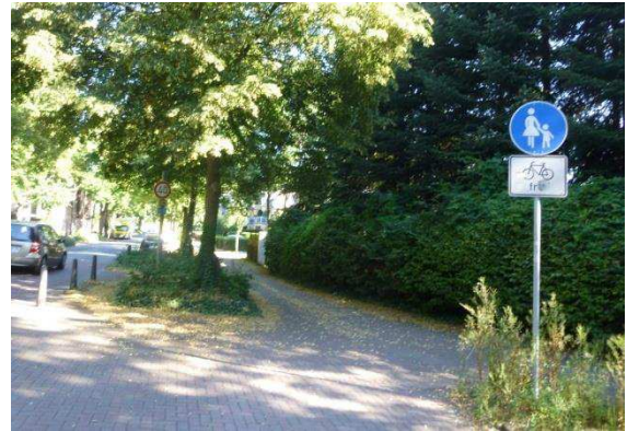
Abbildung 58: freigegebener Gehweg mit einer zu geringen Breite auf der Schloßstraße
