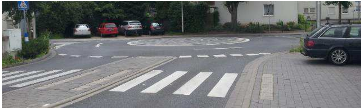
Abbildung 105: Minikreisverkehr
