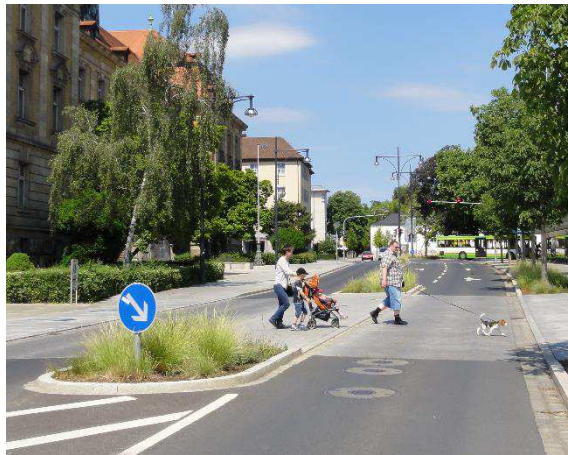
Abbildung 103: Mittelinsel mit Belagswechsel
