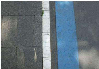
Abbildung 114: Beispiel für Noppensteine zwischen Fuß- und Radwegen
