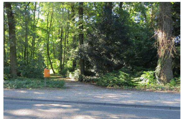
Abbildung 35: Fehlende Bordabsenkung Heinrich-Nottebaum-Str.
