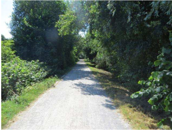
Abbildung 61: Selbstständiger gemeinsamer Geh- und Radweg nördlich des Gustav-Heinemann-Schulzentrums mit ausreichender Breite
