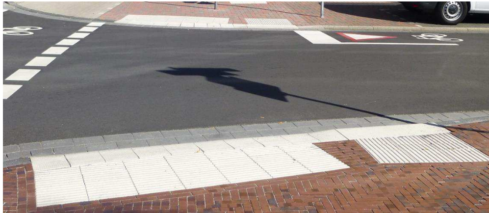
Abbildung 106: Prinzip der Doppelquerung (Nullabsenkung zzgl. Kante)
